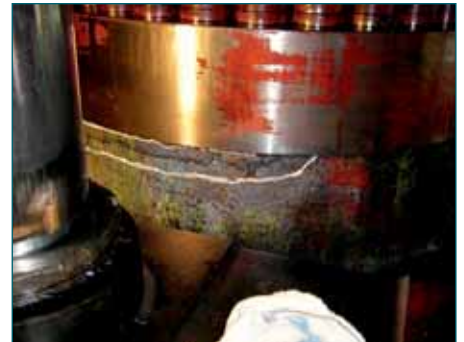
Beschädigtes Kopfstück, 2000 t-Press, Rissbereiche weiß gekennzeichnet.
