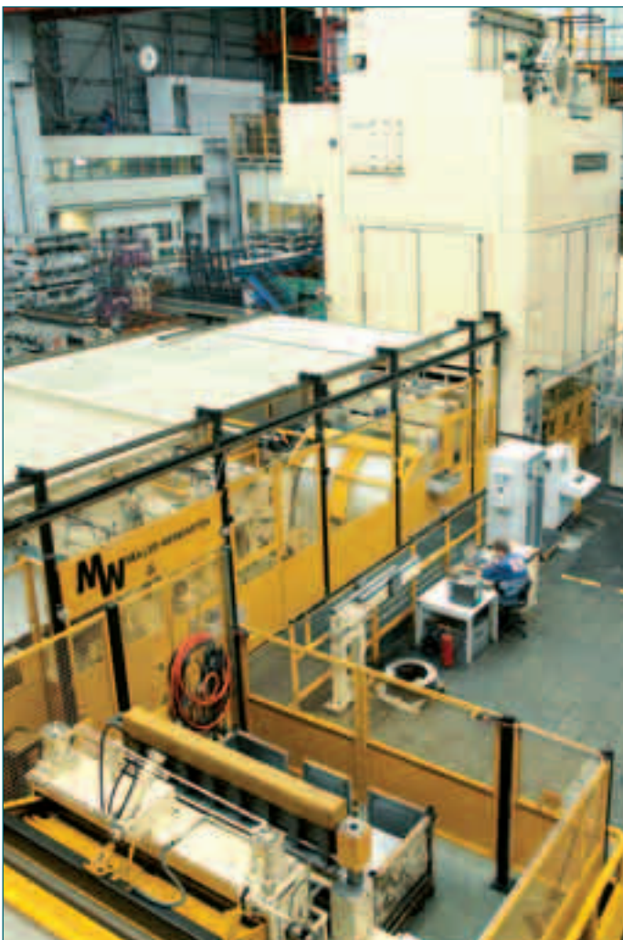
Gesamtansicht der Bandanlage Alle Bilder: Presstec
